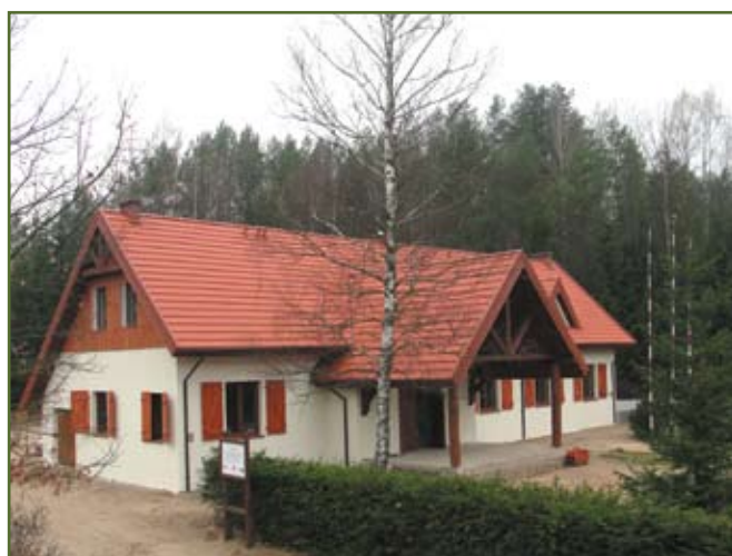
Budynek Warminsko-Mazurskiego Centrum Edukacji Ekologicznej w Gutkowie - obecny stan
